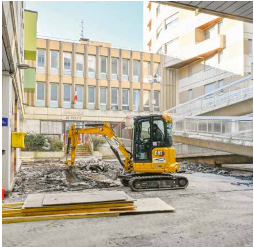
↑ L'étanchéité et le revêtement de la galerie du Quadrant sont en cours de rénovation.
